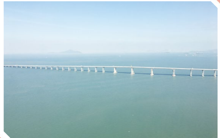
港珠澳大橋香港接線 The Hong Kong-Zhuhai-Macao Bridge Hong Kong Link Road
