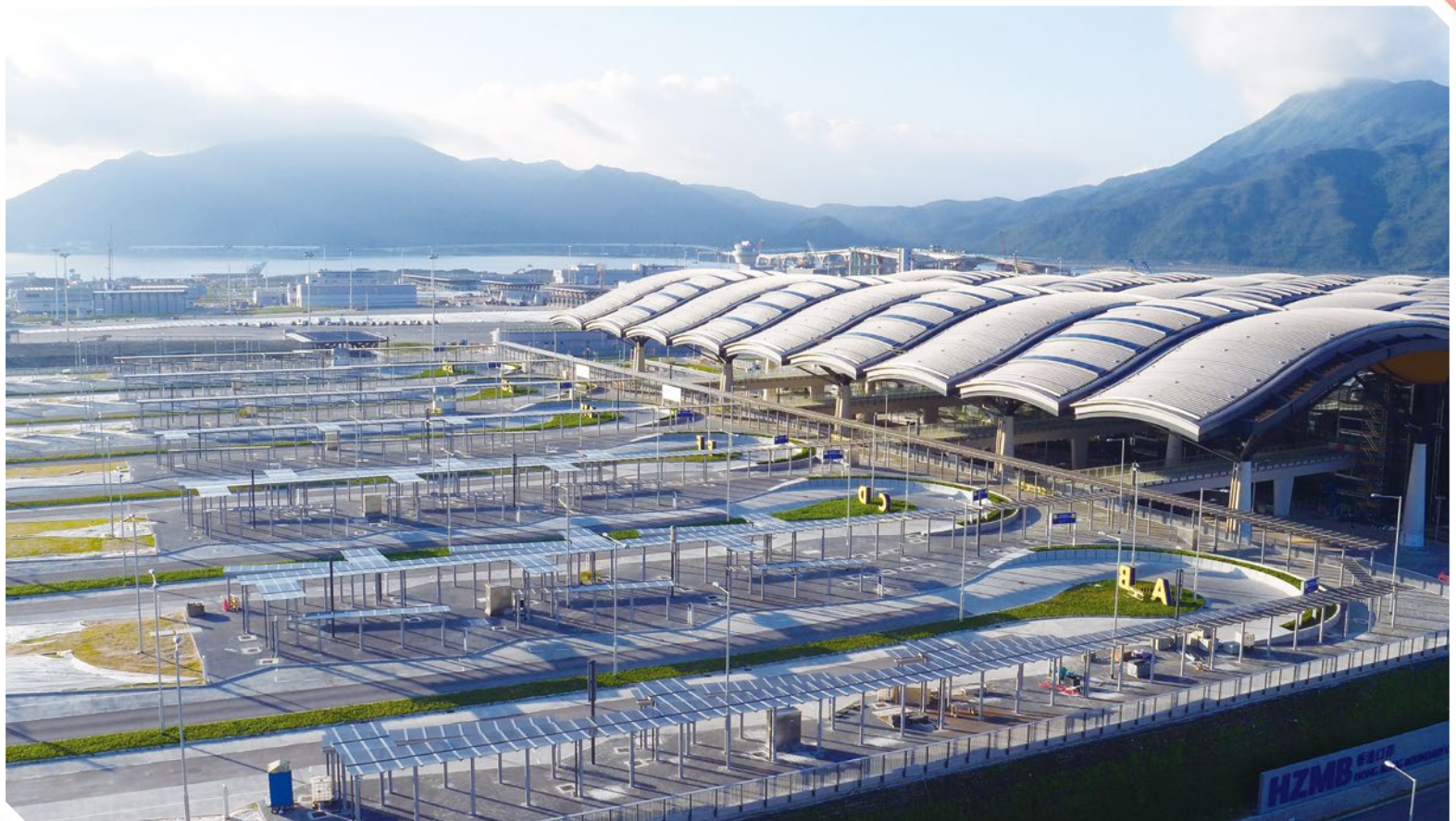
香港口岸公共運輸交匯處 Public Transport Interchange at Hong Kong Port
