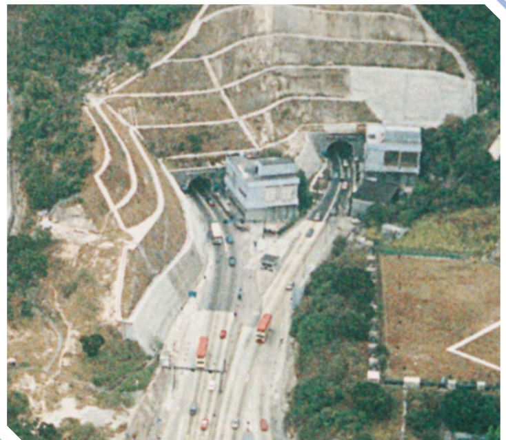
獅子山隧道 Lion Rock Tunnel
