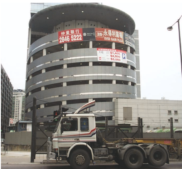
多層貨車停車場
