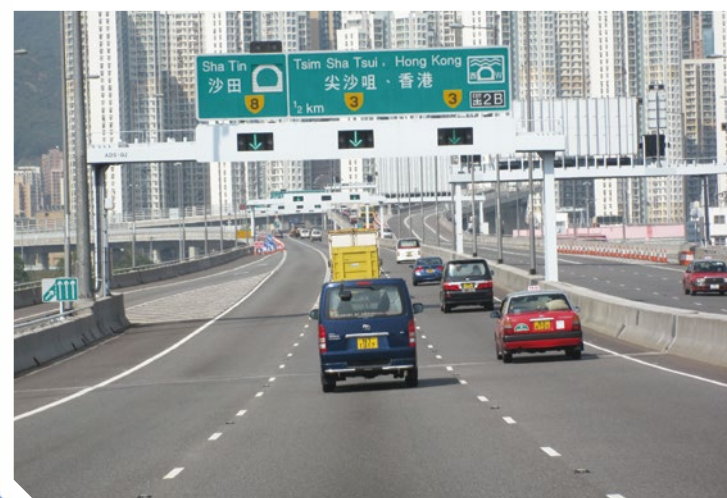
可變訊息顯示牌及行車線管制燈號 Variable message signs and lane control signals
