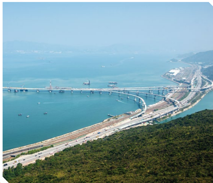
屯門至赤鱸角連接路—南面連接路高架路段（鳥瞰圖） Tuen Mun-Chek Lap Kok Link – Southern Connection Viaduct Section (aerial view)
