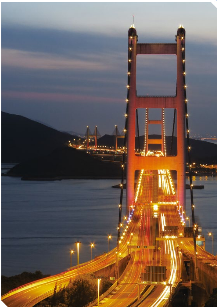
青馬大橋 Tsing Ma Bridge
