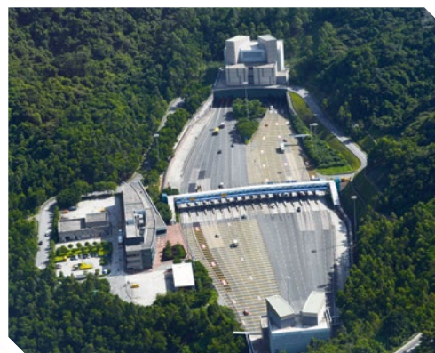
八號幹線沙田嶺 隧道（收費廣場） Route 8 Sha Tin Heights Tunnel (Toll Plaza)
