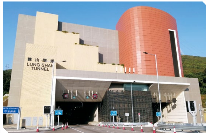
龍山隧道 Lung Shan Tunnel
