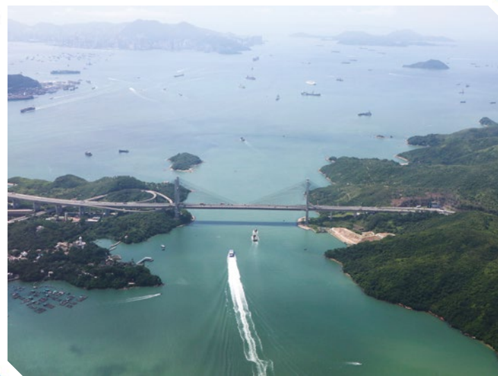
青馬大橋、汲水門大橋 Tsing Ma Bridge and Kap Shui Mun Bridge
