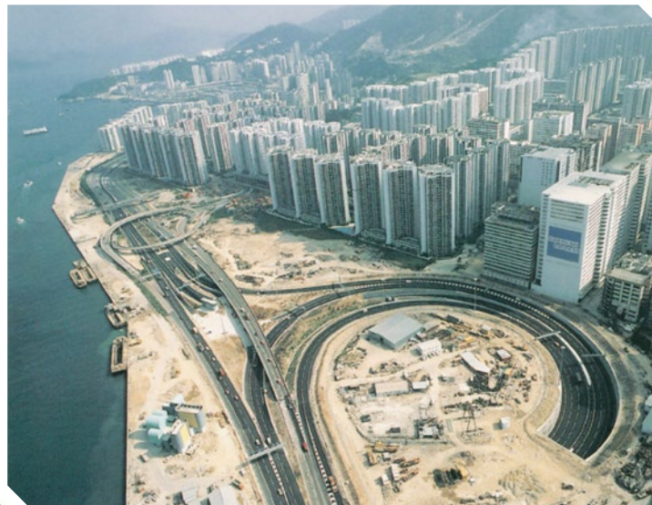
東區海底隧道 Eastern Harbour Crossing
