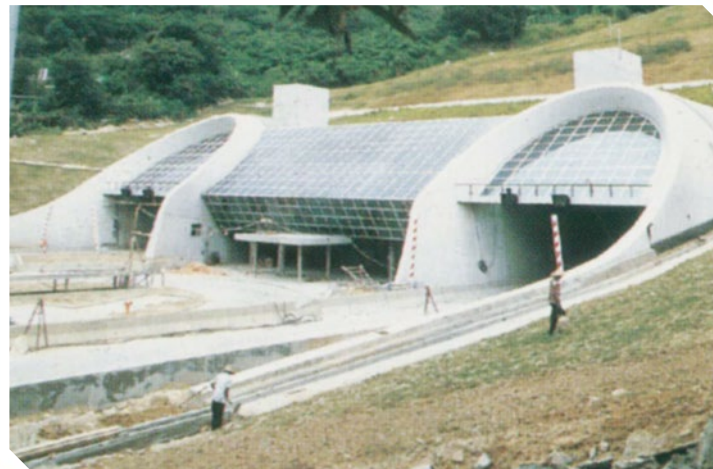
香港仔隧道 Aberdeen Tunnel
