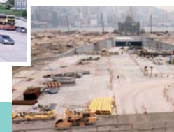
建造中的西區海底隧道 Western Harbour Crossing under construction
