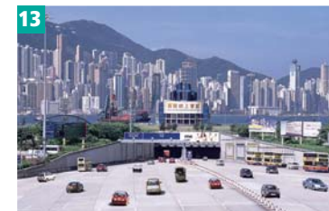
西區海底隧道 The Western Harbour Crossing
