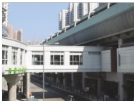
連接馬鞍山站的行人天橋。 Footbridge connecting Ma On Shan Station.
