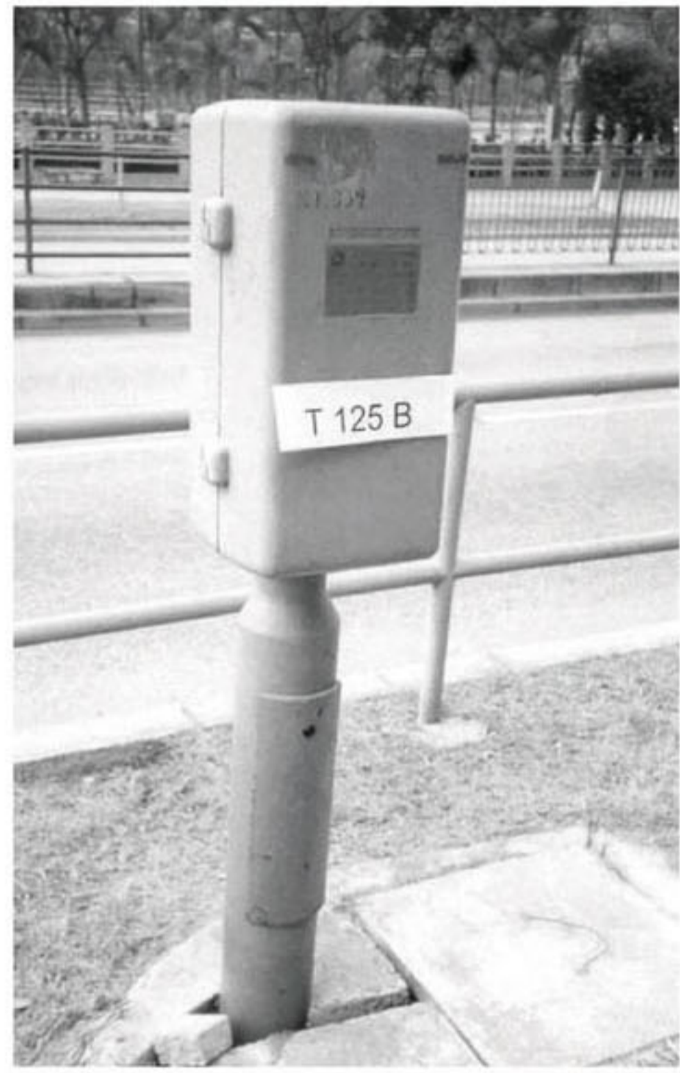
於八十年代普遍採用的T125型號交通燈控制箱，俗稱「豬仔機」
