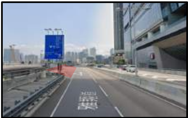
雅翔道天橋 Nga Cheung Road Flyover
