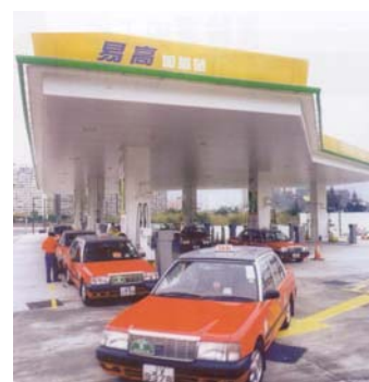
石油氣加氣站
