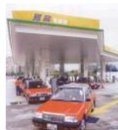
石油氣加氣站
