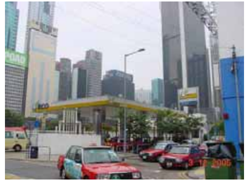
石油氣加氣站
