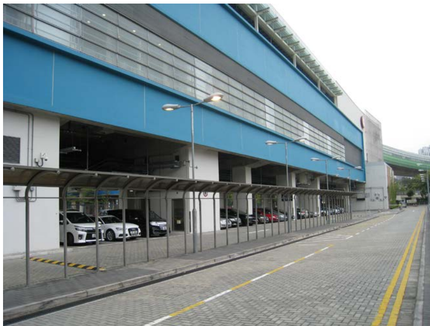
海洋公園站泊車轉乘設施
