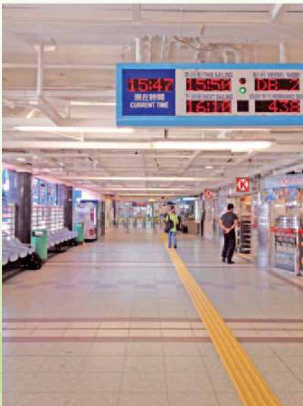
渡轮码头内的触觉引路径 Tactile guide path at pier
