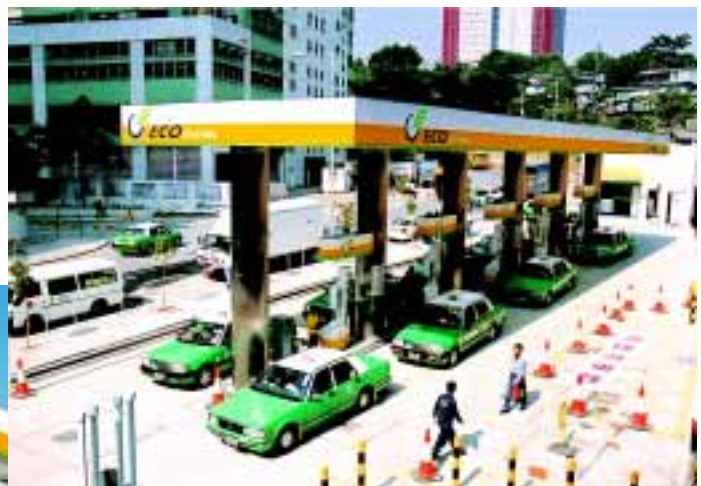
屯門石油氣加氣站
