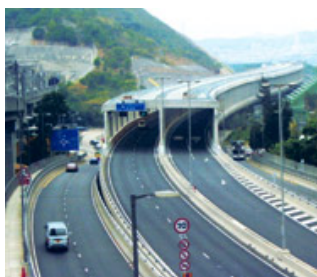
青衣北岸公路 -- 担杆山高架路。 Tsing Yi North Coastal Road -- Tam Kon Shan Viaduct.
